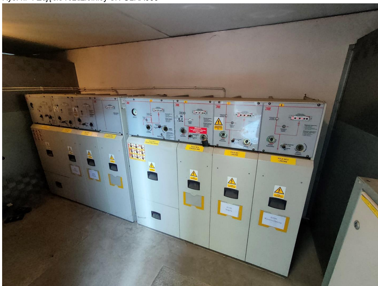
Rys. nr 4 Zdjęcie rozdzielnic SN GLRA033
